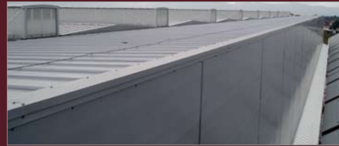
PROYECTO_ IFEVI (Instituto Ferial de Vigo). 10.000 m 2 de panel sandwich de cubierta, 5.000 m 2 de policarbonato translúcido en cubierta, 2.500 m 2 de panel arquitectónico fachadas, 1.500 m 2 de policarbonato translúcido en fachadas | CLIENTE_ LITE FCC Construcción, S.A. - Construcciones Conde, S.A.
