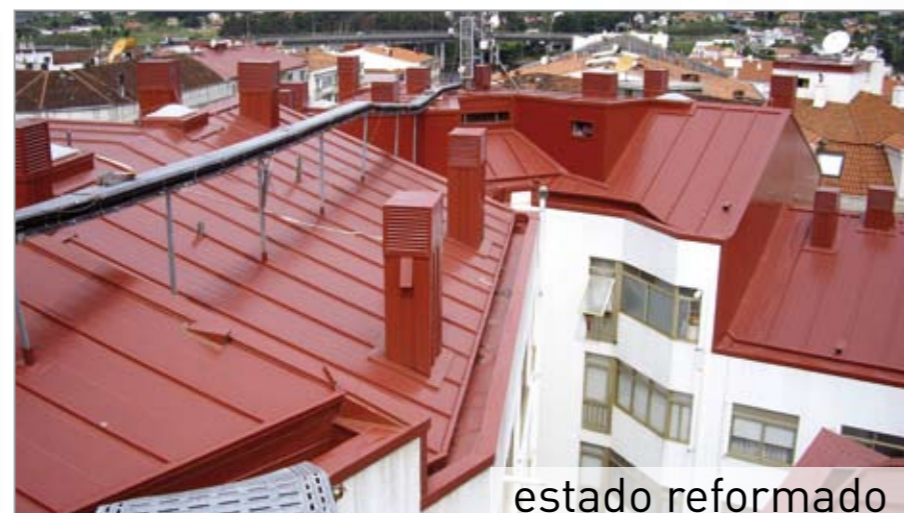
> PROYECTO_ Rehabilitación de cubierta de la comunidad de propietarios del edificio Lians, Pontevedra. 2.500 m 2 de panel sandwich de cubierta
