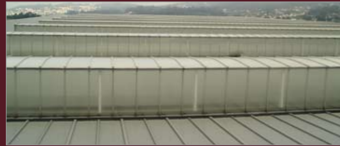
PROYECTO_ IFEVI (Instituto Ferial de Vigo). 10.000 m 2 de panel sandwich de cubierta, 5.000 m 2 de policarbonato translúcido en cubierta, 2.500 m 2 de panel arquitectónico fachadas, 1.500 m 2 de policarbonato translúcido en fachadas | CLIENTE_ LITE FCC Construcción, S.A. - Construcciones Conde, S.A.
