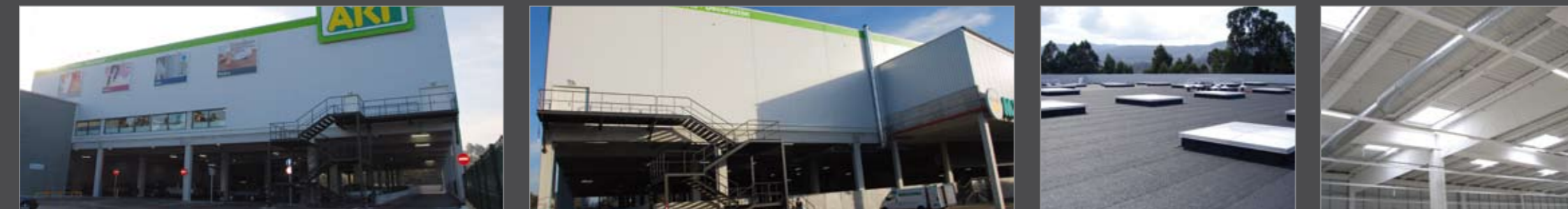
PROYECTO_ Centro comercial en Mos - Pontevedra. 3.200 m 2 cubierta Deck con sus correspondientes sistemas de iluminación y ventilación, 2.000 m 2 panel sandwich arquitectónico | CLIENTE_ Nieto y Cid, S.L.
