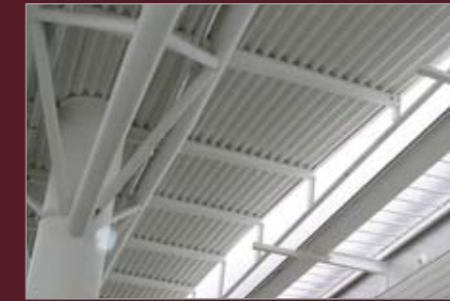
PROYECTO_ IFECO (Instituto Ferial de A Coruña). 3.000 m 2 de cubierta de policarbonato, 5.000 m 2 de fachadas de panel sandwich de lana de roca, 2.000 m 2 de panel ondulado de fachadas | CLIENTE_ TECONSA
